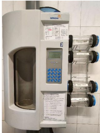
Получение пробирки с образцом крови с помощью пневмопочты
